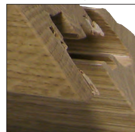
Double joint de frappe à mémoire de forme sur ouvrant
